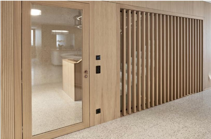
Une architecture passionnante – mise en œuvre à la perfection par notre membre **G. RISSE SA**. Les menuisiers ont installé des portes et des vitrages avec une protection incendie EI30 et EI60, ainsi qu'une isolation acoustique allant jusqu'à 42 dB. Des latices placés devant les vitrages servent de brise-vue.
