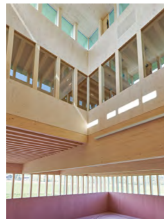
• Vitrages antichute fixes avec protection incendie EI60 en épicea.
